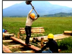
10年周期で毎年約2kmの架替工事を実施 車が入れないためヘリコプターで搬出
