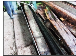
腐食部分を除去
