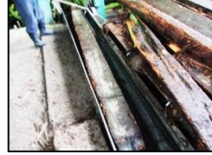
腐食部分を除去
